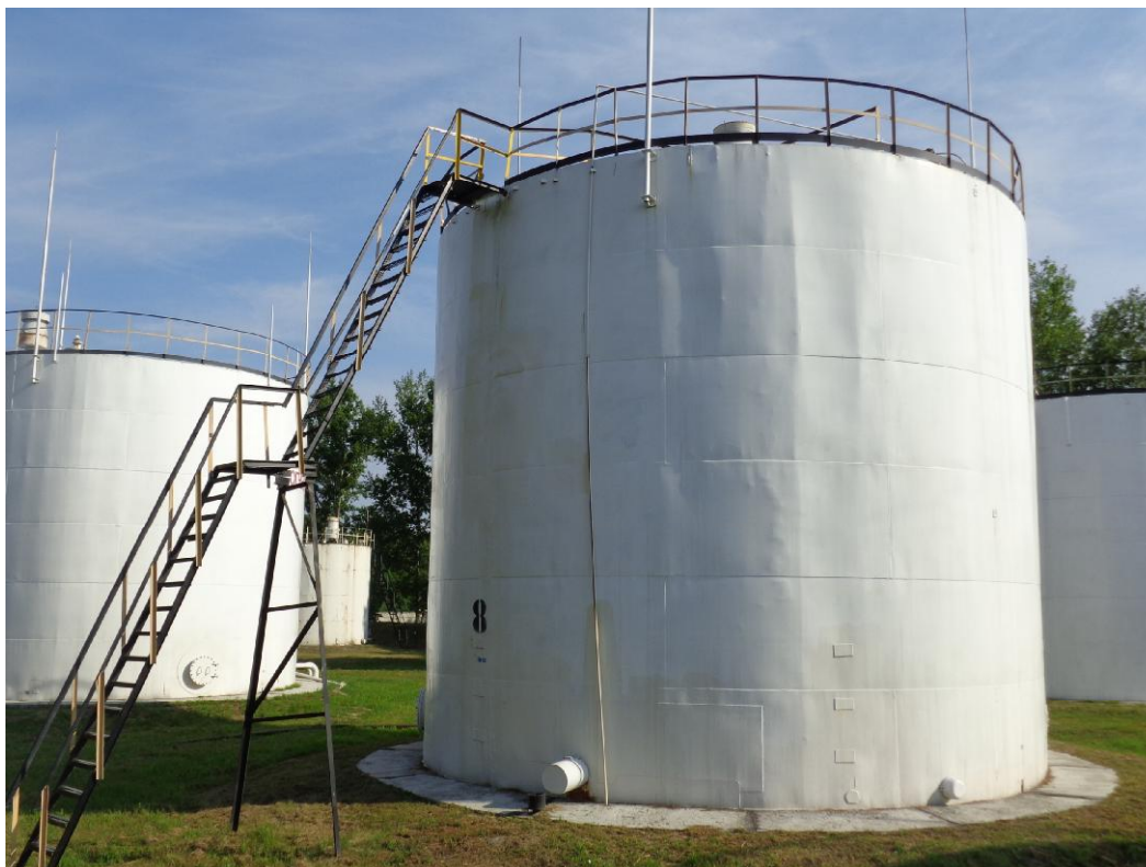
Рисунок 1 - Общий вид резервуара стального вертикального цилиндрического РВС-700
