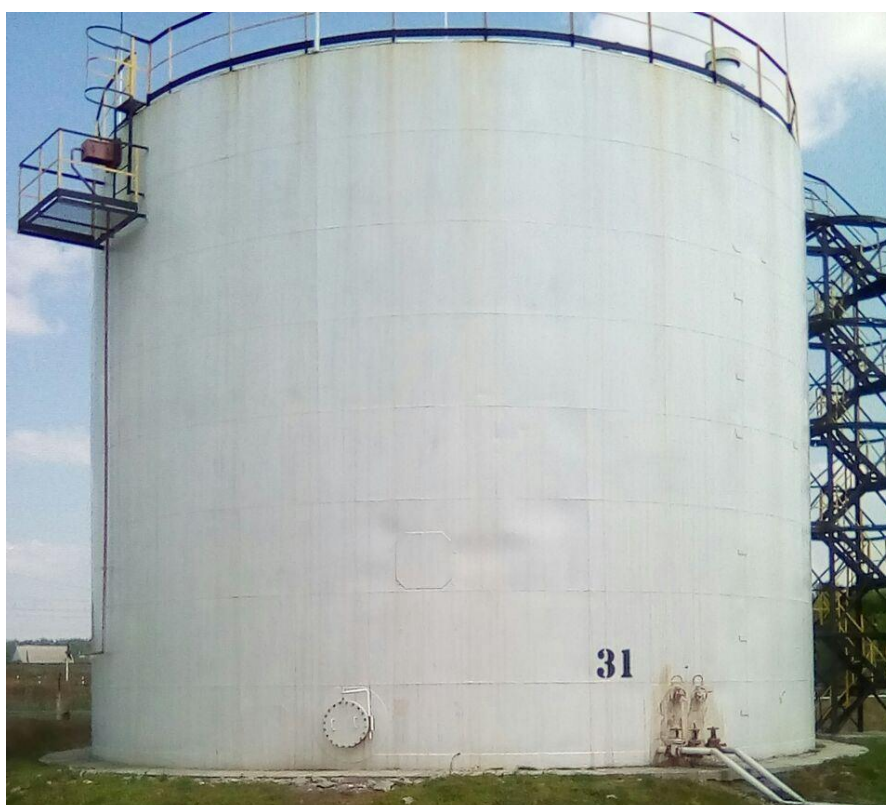
Рисунок 3 - Общий вид резервуара стального вертикального цилиндрического РВС-2000
