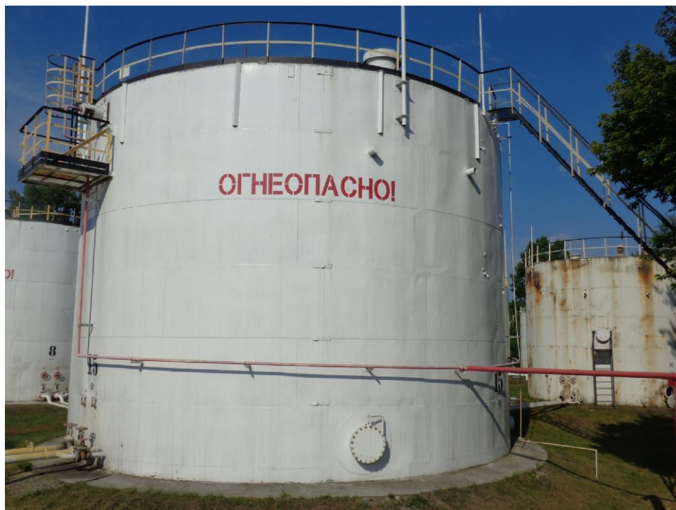
Рисунок 2 - Общий вид резервуара стального вертикального цилиндрического РВС-1000
