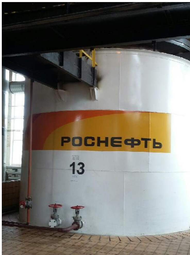
Рисунок 1 - Общий вид резервуара стального вертикального цилиндрического РВС-100
