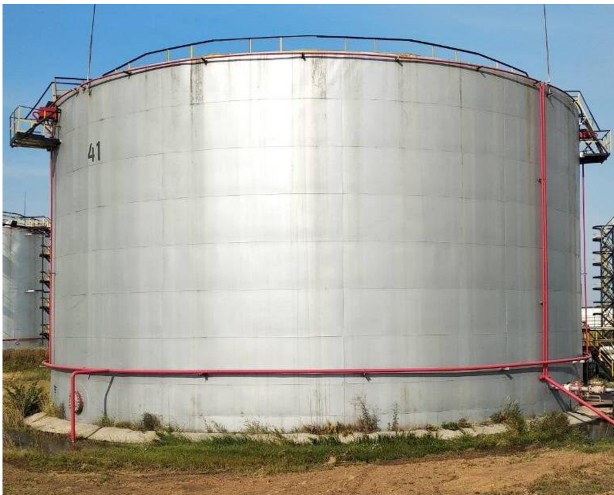
Рисунок 1 - Общий вид резервуара стального вертикального цилиндрического РВС-5000
