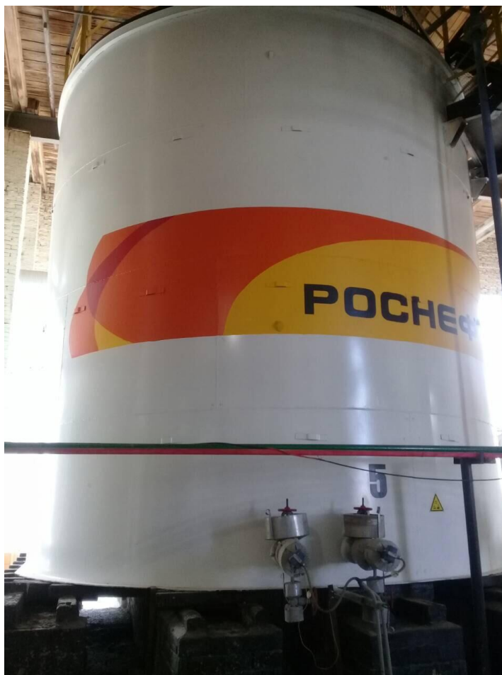
Рисунок 2 - Общий вид резервуара стального вертикального цилиндрического РВС-200
