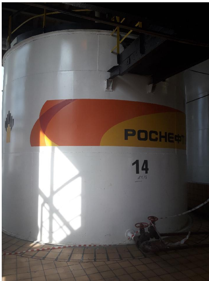
Рисунок 1 - Общий вид резервуара стального вертикального цилиндрического РВС-100
