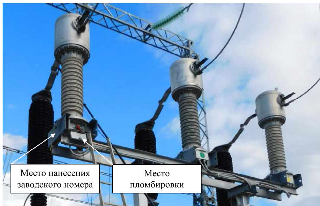
Рисунок 1. Общий вид средства измерений с указанием места пломбировки, места нанесения заводского номера
