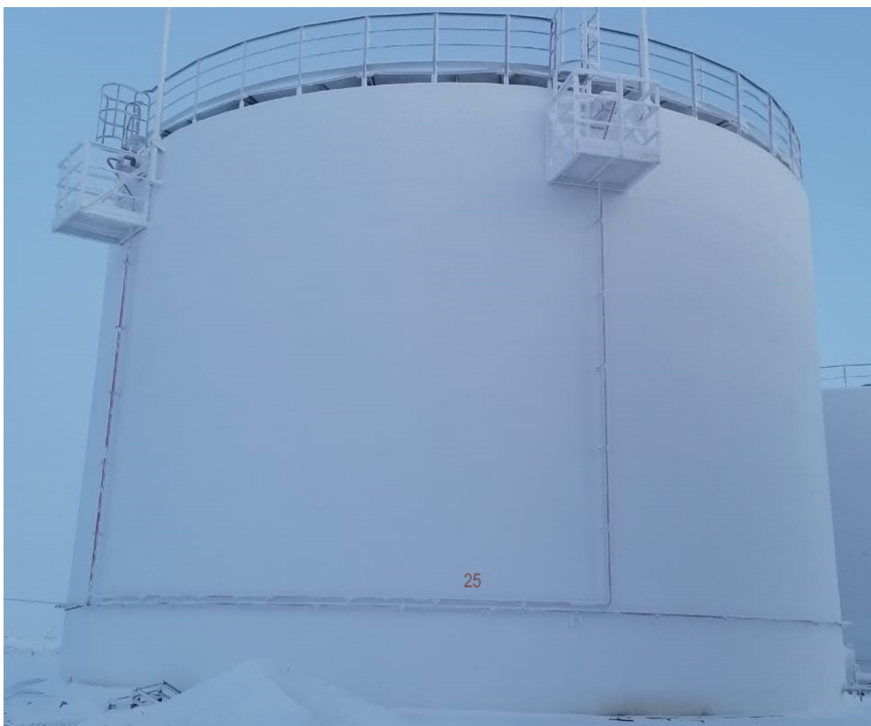
Рисунок 1 – Общий вид резервуара РВС-3000
