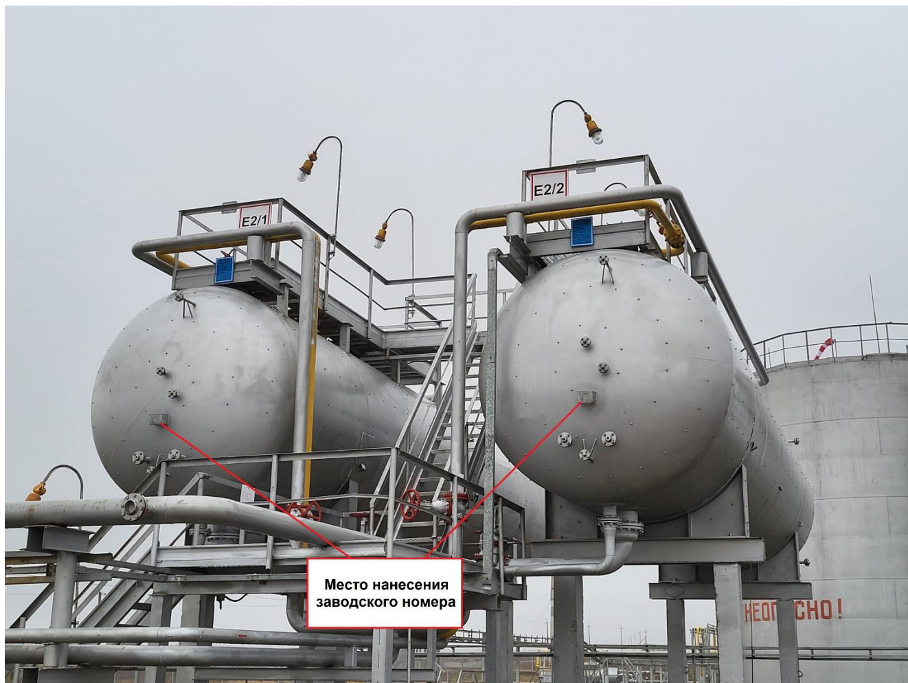
Рисунок 1 - Общий вид резервуаров горизонтальных стальных цилиндрических РГС- 100 с указанием места установки таблички с заводским номером
