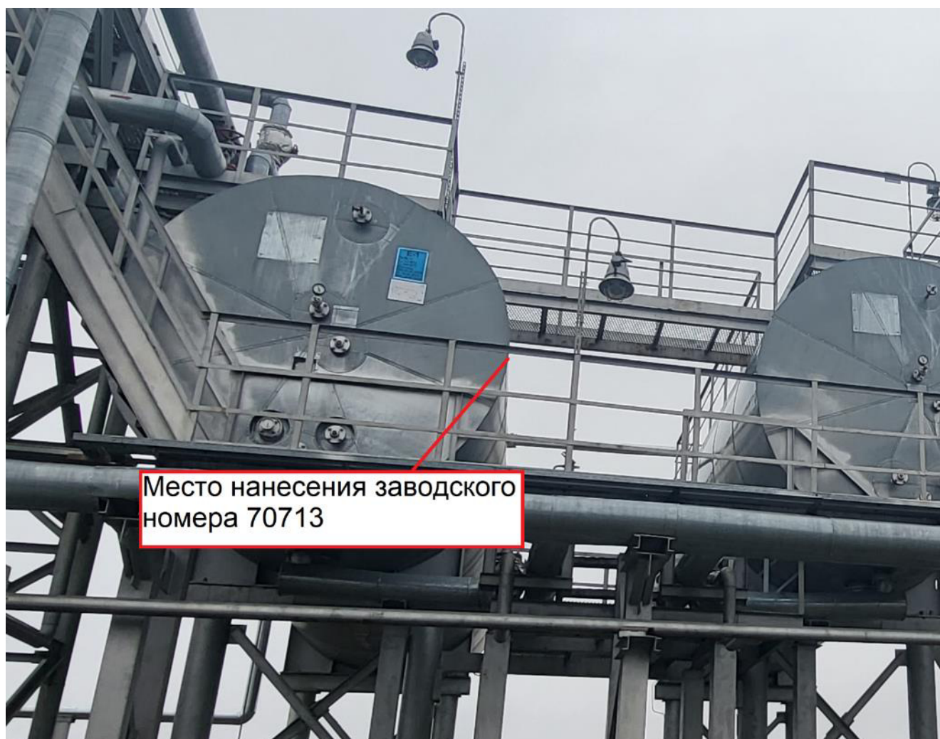
Рисунок 1 - Общий вид резервуара горизонтального стального цилиндрического РГС- 80 с указанием места нанесения заводского номера
