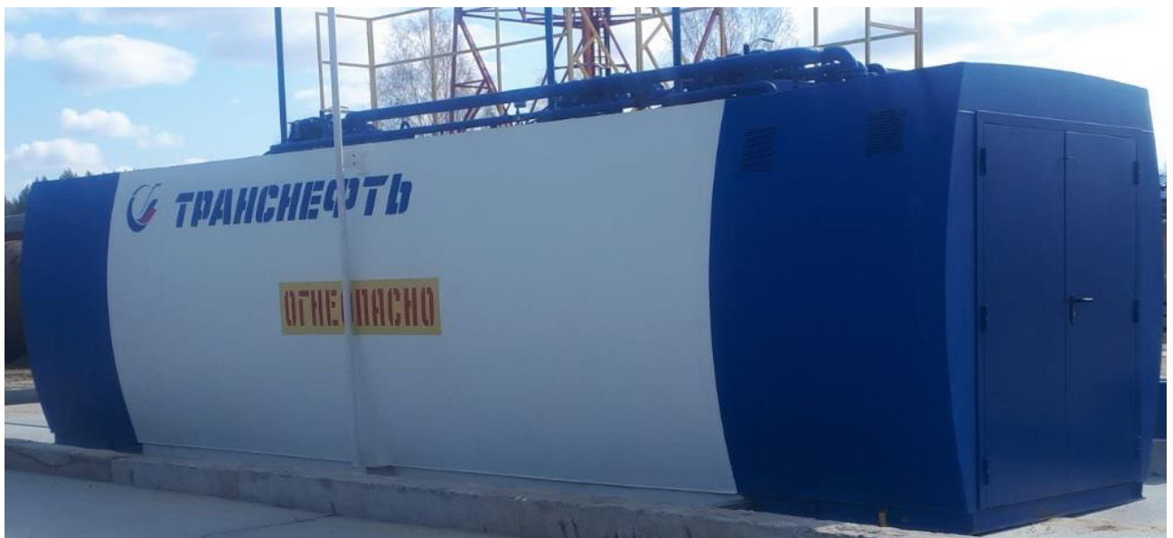
Рисунок 1 – Общий вид резервуара РГС-35
