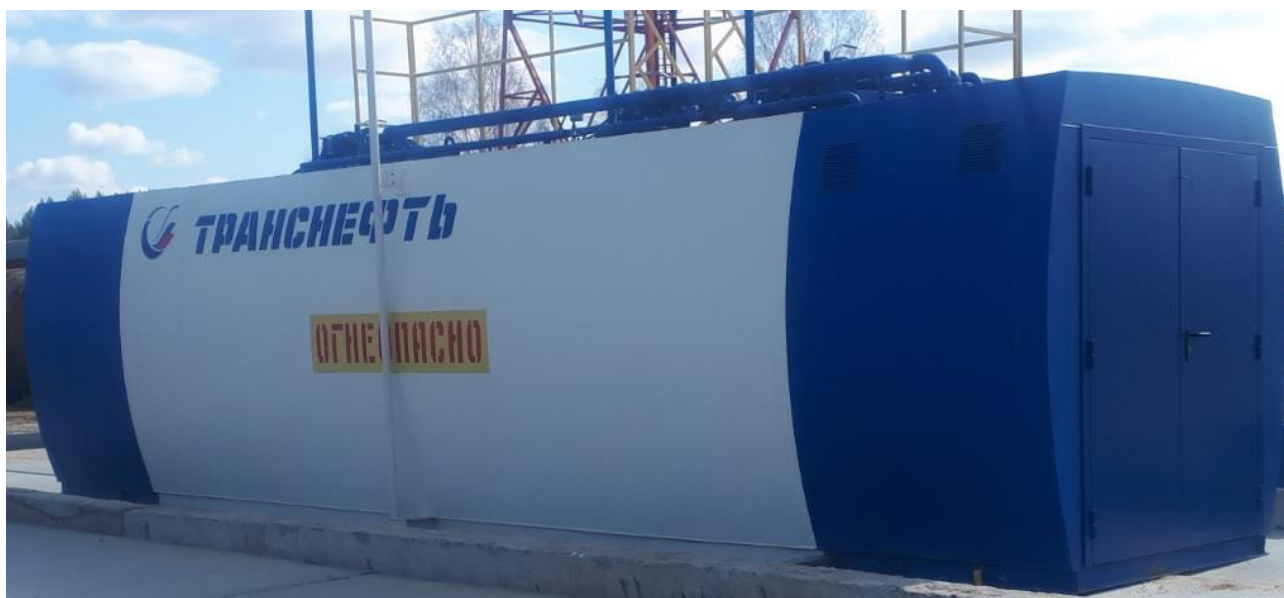
Рисунок 1 – Общий вид резервуара РГС-35
