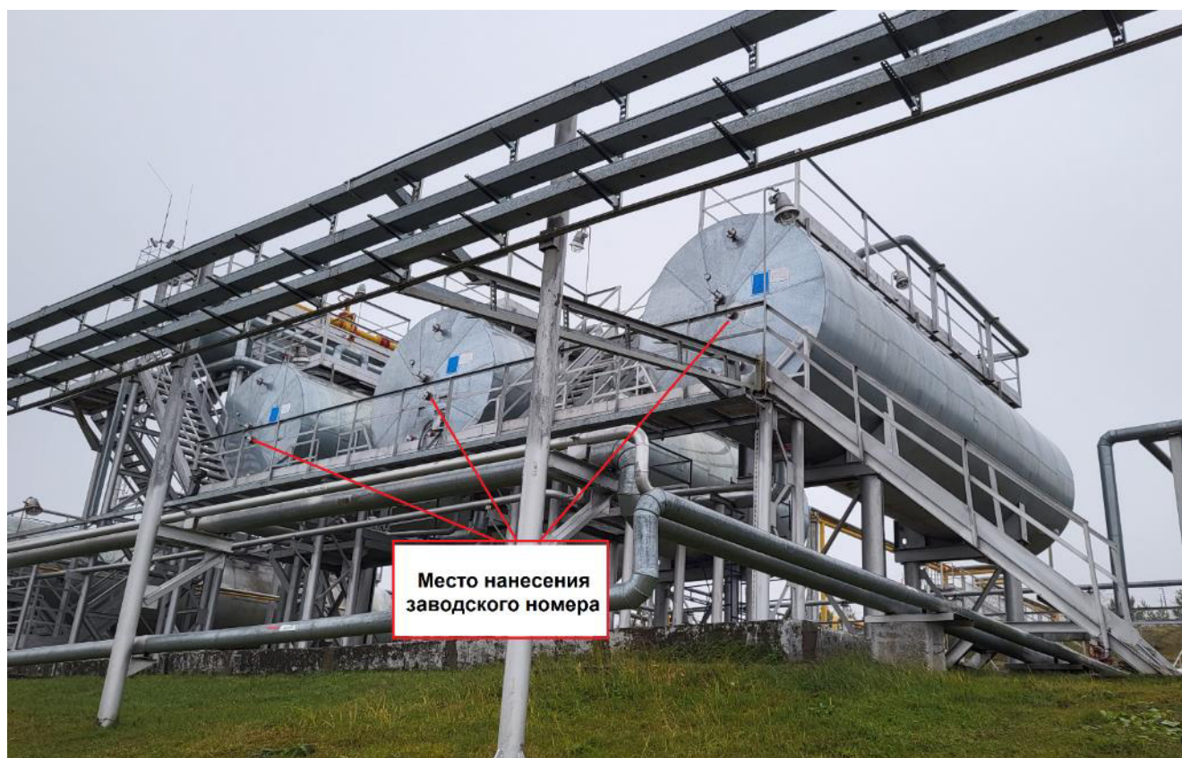
Рисунок 1 - Общий вид резервуаров горизонтальных стальных цилиндрических РГС- 80 с указанием места установки таблички с заводским номером
