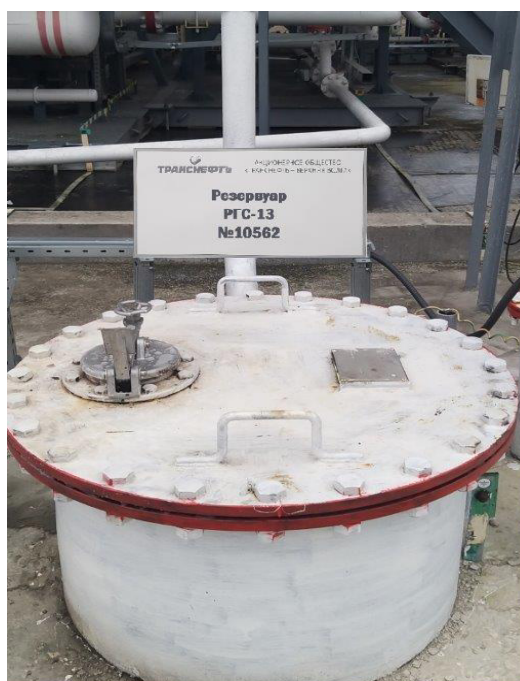
Рисунок 1 – Общий вид резервуара РГС-13
