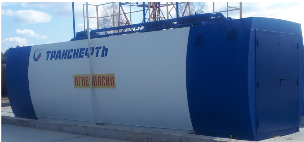
Рисунок 1 – Общий вид резервуара РГС-35
