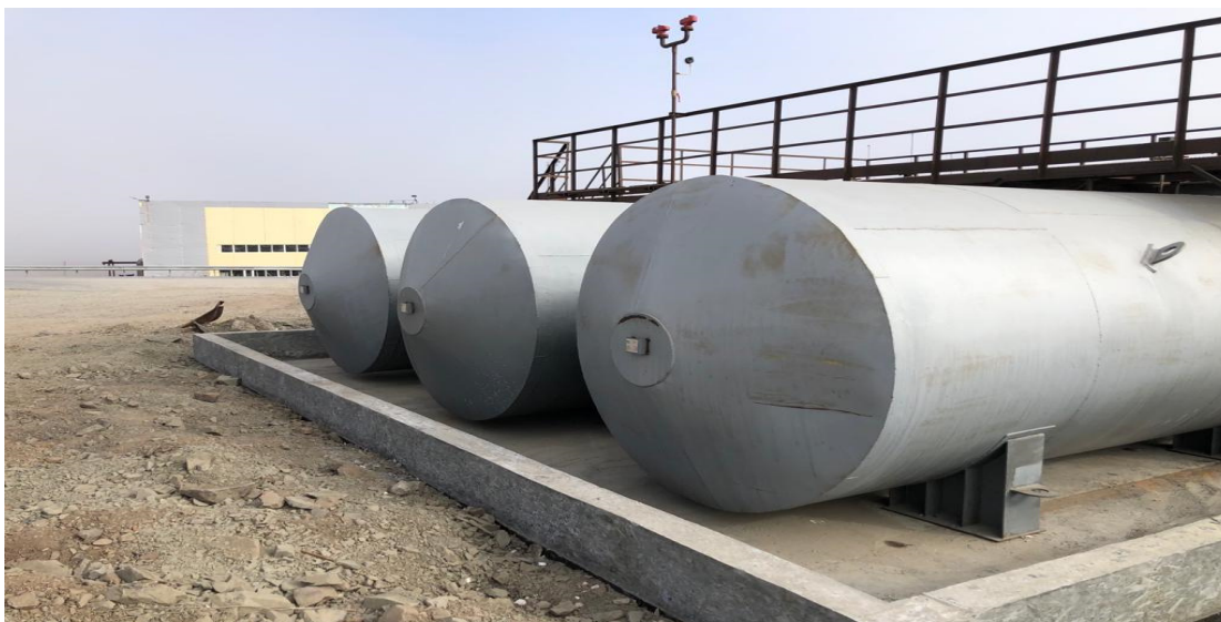
Рисунок 1 – Общий вид резервуаров РГСД-60 №000105, №000106, №000107
