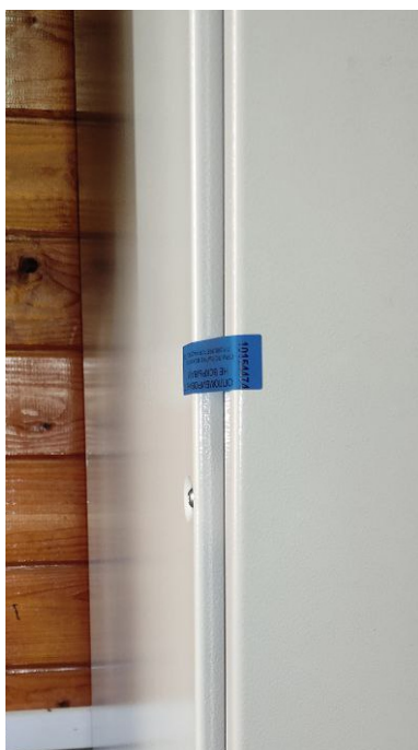
Рисунок 4 – Схема пломбировки шкафа СОИ
