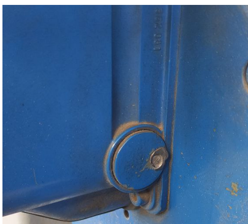
Рисунок 7 – Схема пломбировки крышки регулировочного винта счетчика
