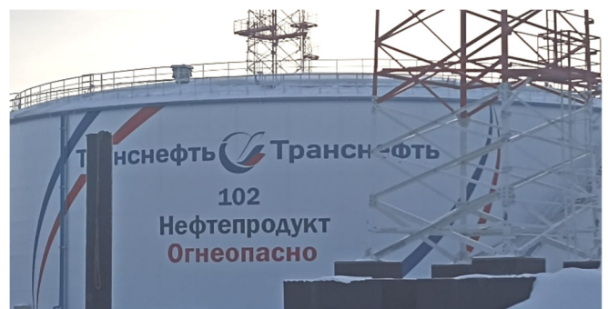
Рис. 2 – Общий вид РВС-20000 зав.№101
