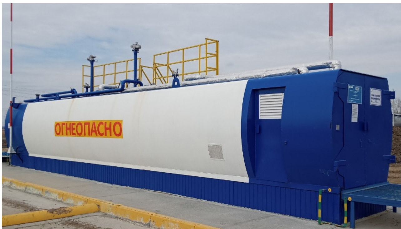
Рисунок 2 – Общий вид резервуара РГС-30
