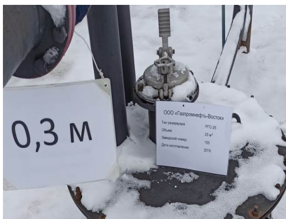
Рисунок 2 – Маркировочная табличка резервуара РГС-25
