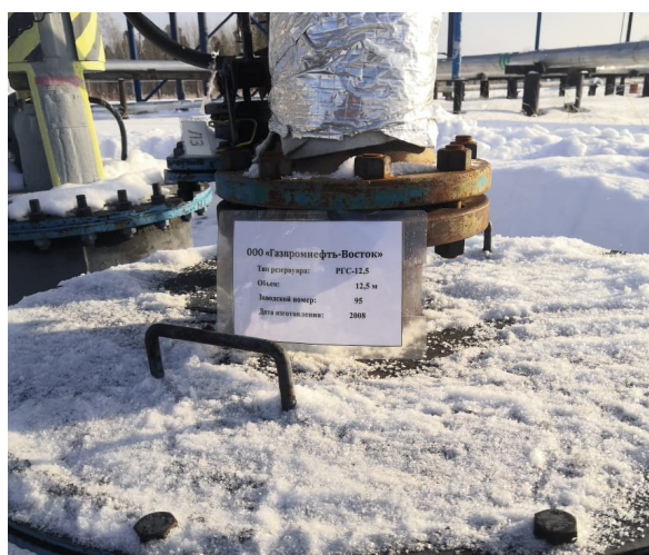
Рисунок 2 – Маркировочная табличка резервуара РГС-12,5
