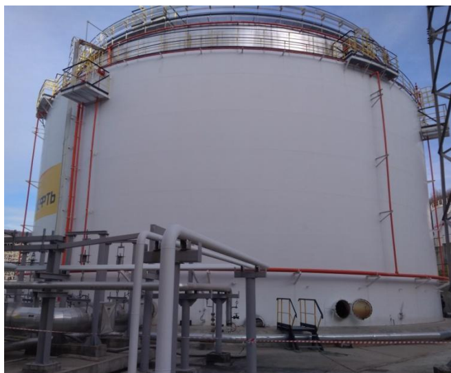
Рисунок 1 - Общий вид резервуаров РВС-3000
