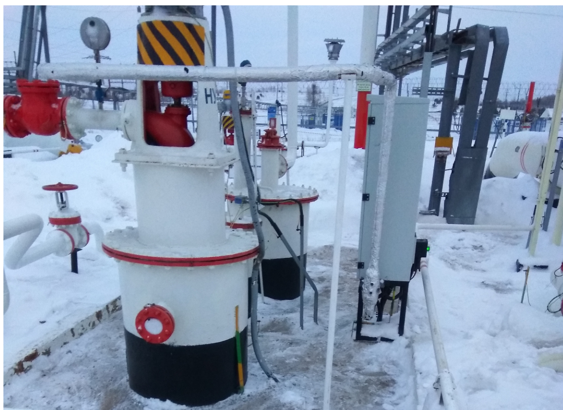
Рисунок 2 – Общий вид резервуара ЕП-16-2000-1424-1 зав.№ 42739
