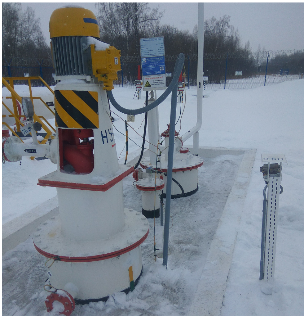
Рисунок 3 – Общий вид резервуара ЕП-16-2000-1424-1 зав.№ 42740
