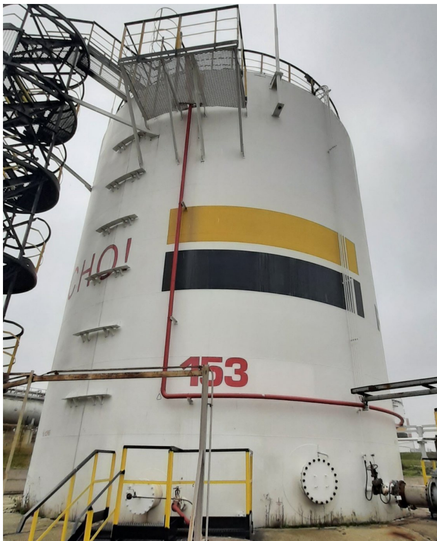
Рисунок 1 – Общий вид резервуара РВСП-1000 №153
