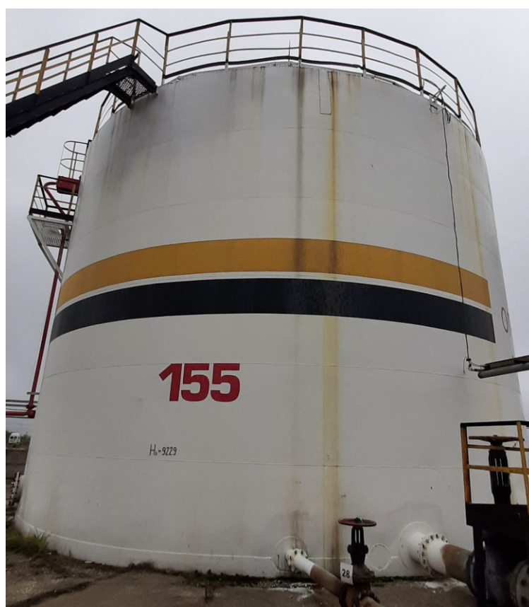
Рисунок 2 – Общий вид резервуара РВС-1000 №155
