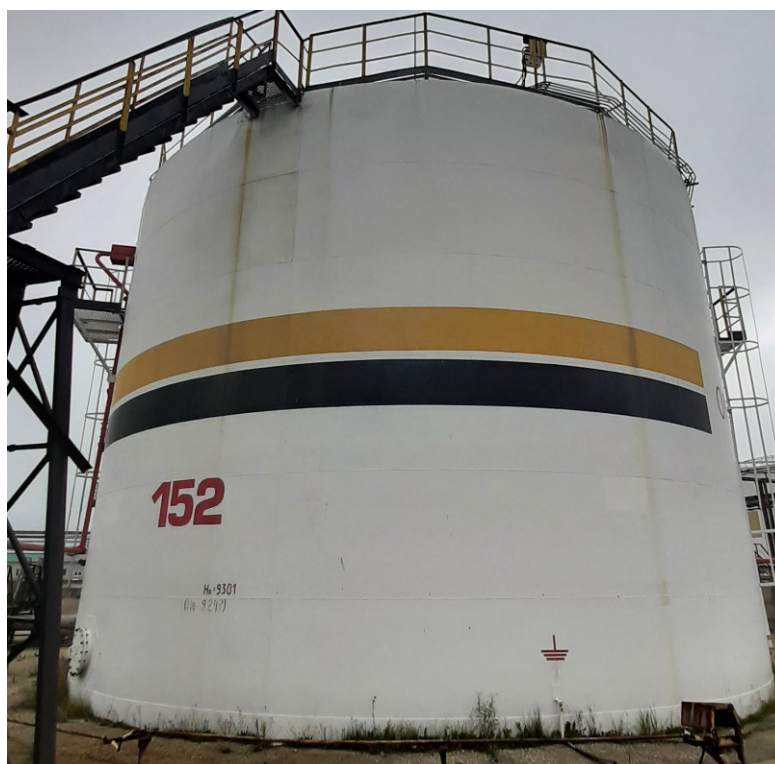
Рисунок 1 – Общий вид резервуара РВС-1000 №152
