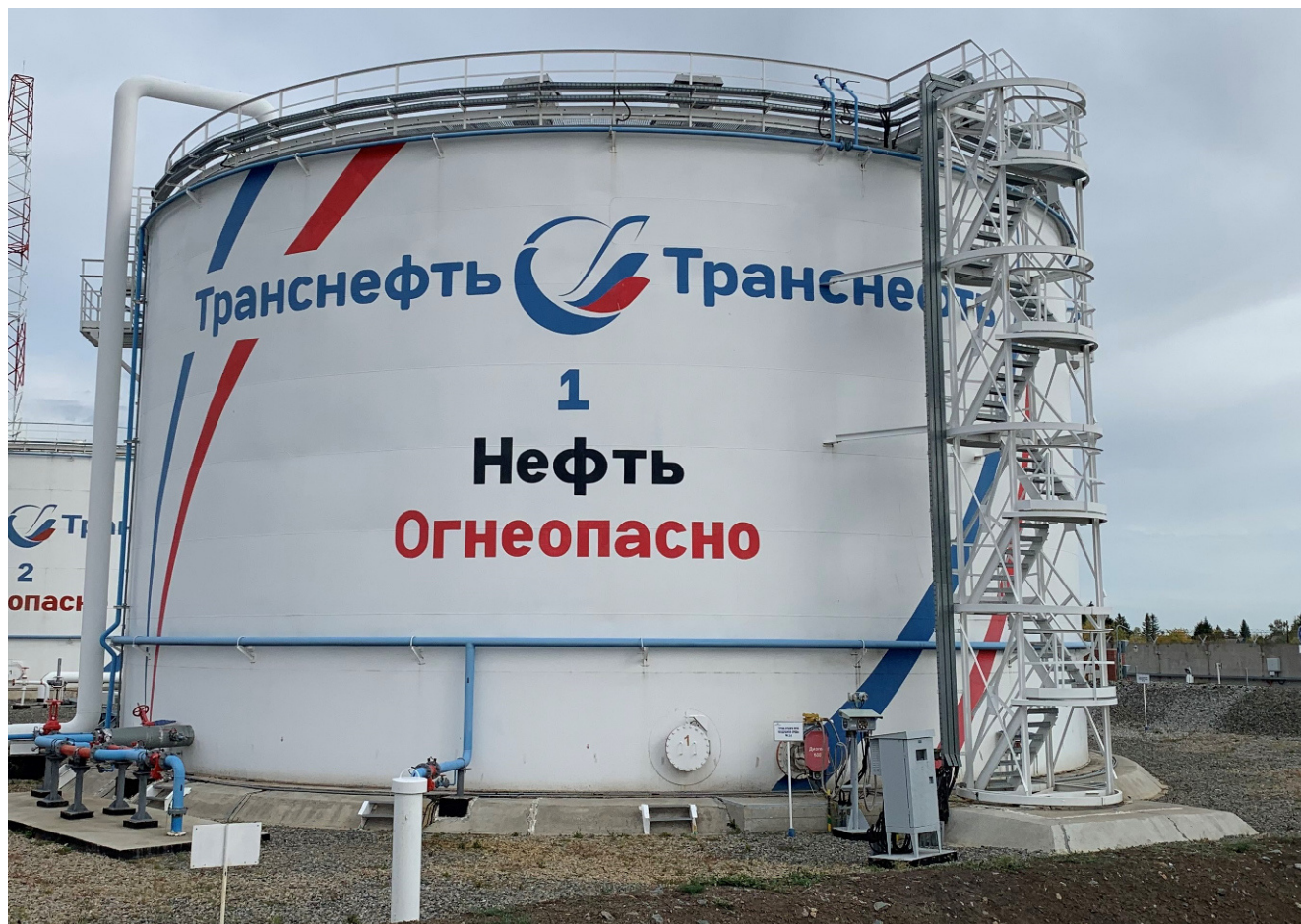
Рисунок 1 – Общий вид резервуара РВС-5000 №1
