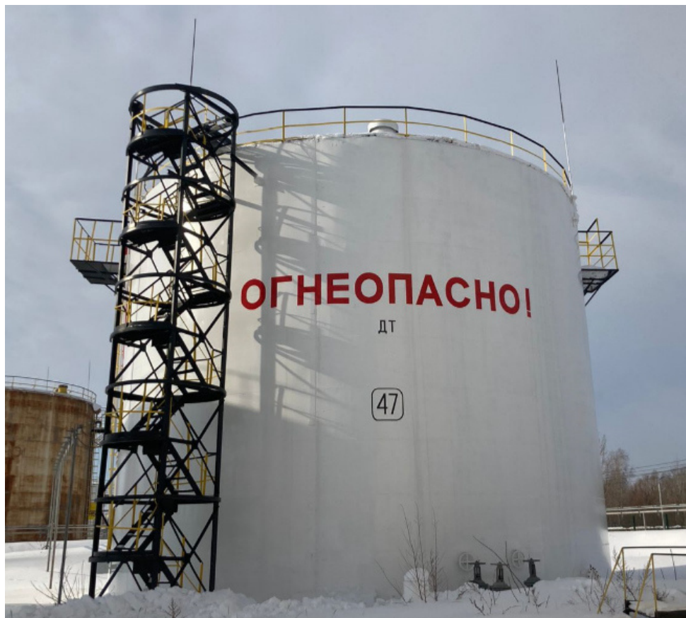
Рисунок 1 – Общий вид резервуара стального вертикального цилиндрического РВС-2000, зав. №47
