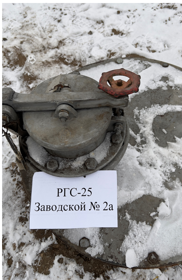
Рисунок 2 – Общий вид резервуара
