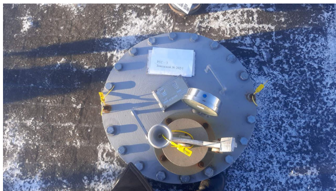
Рисунок 2 – Общий вид резервуара РГС-3 № 202/1
