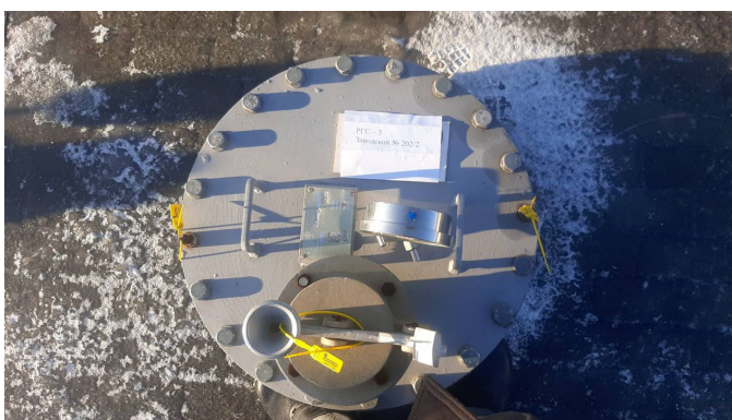
Рисунок 4 – Общий вид резервуара РГС-3 № 202/3
