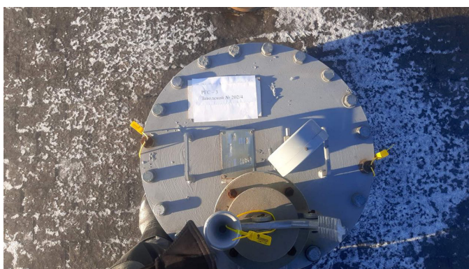
Рисунок 5 – Общий вид резервуара РГС-3 № 202/4
