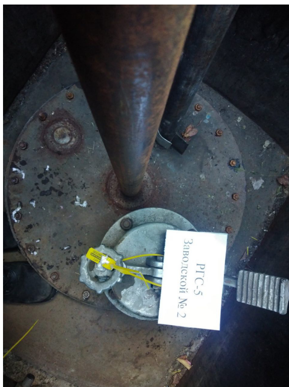
Рисунок 3 – Общий вид резервуара РГС-5 № 2
