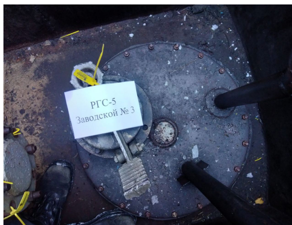
Рисунок 4 – Общий вид резервуара РГС-5 № 3
