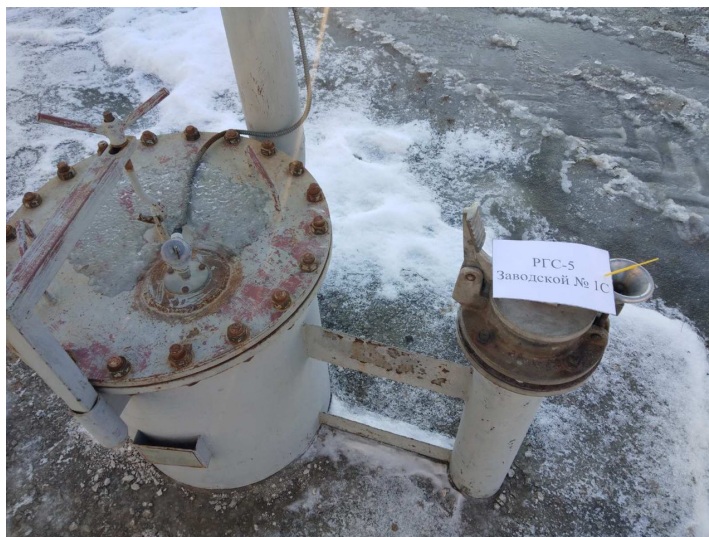
Рисунок 5 – Общий вид резервуара РГС-5 № 1С
