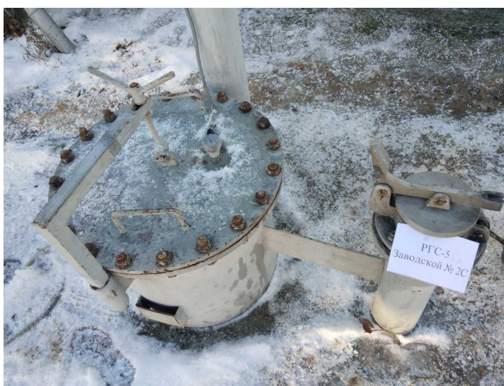
Рисунок 6 – Общий вид резервуара РГС-5 № 2С
