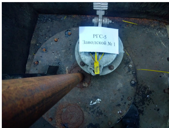
Рисунок 2 – Общий вид резервуара РГС-5 № 1
