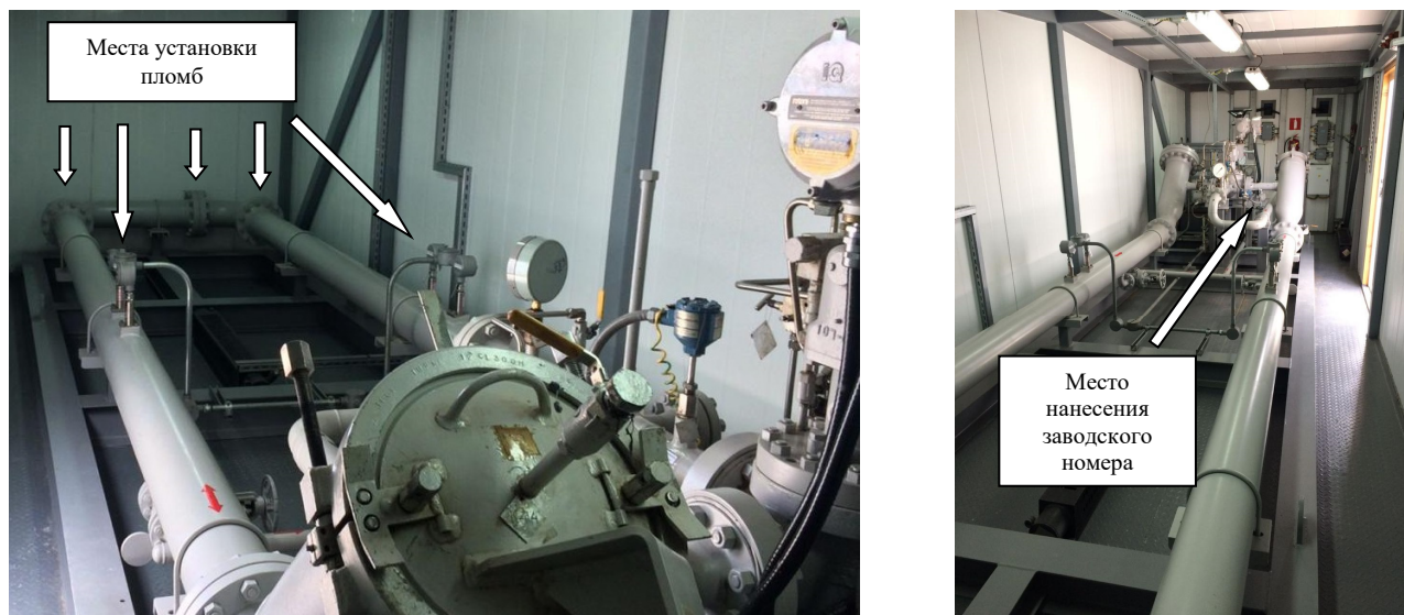
Рисунок 1 - Общий вид ТПУ с указанием мест установки пломб, заводского номера
