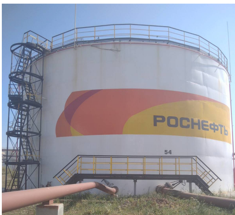
Рисунок 1 – Общий вид резервуара РВС-5000
