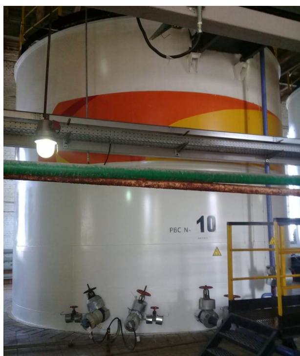
Рисунок 1 – Общий вид резервуаров РВС-200
