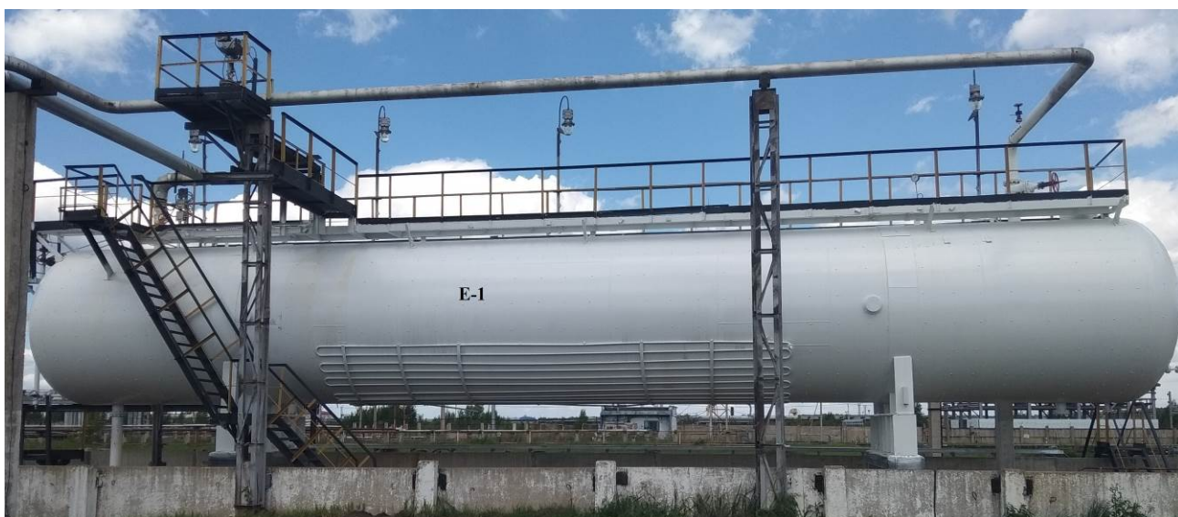
Рисунок 1 – Общий вид резервуара РГС-200
