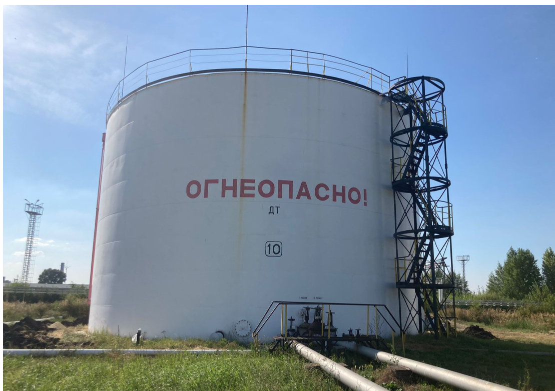
Рисунок 1 - Общий вид резервуара стального вертикального цилиндрического РВС-3000, Зав. №10
