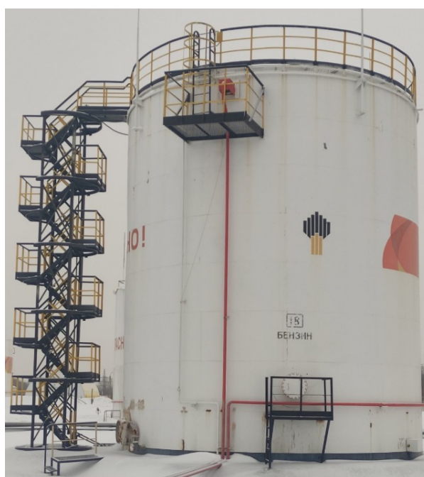
Рисунок 1 – Общий вид резервуара РВСП-1000
