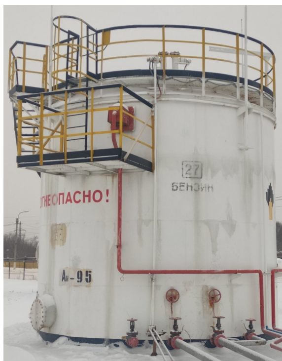
Рисунок 1 – Общий вид резервуара РВСП-200
