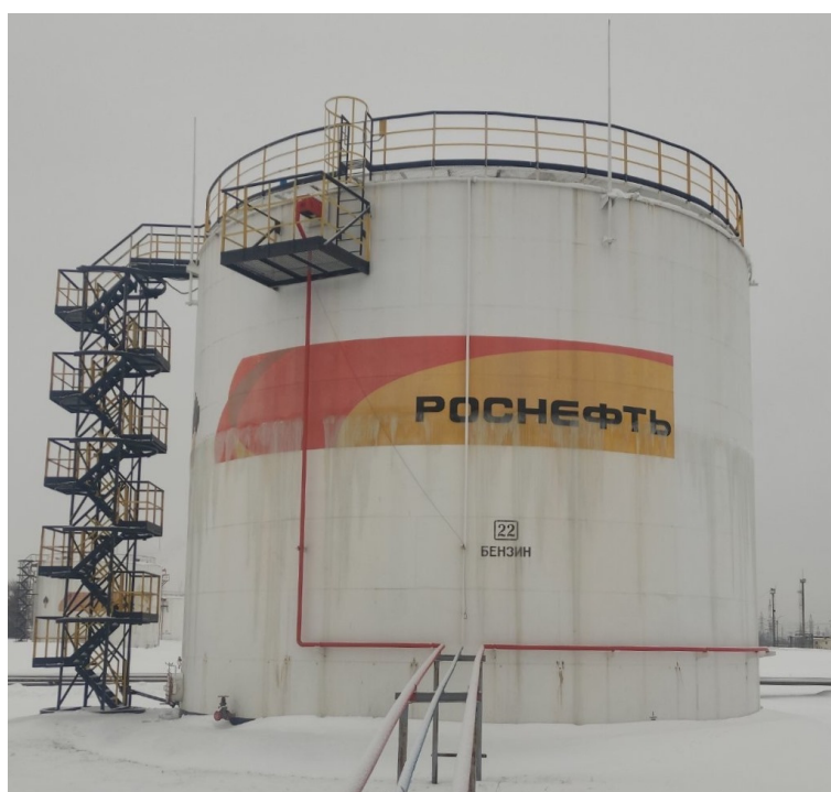
Рисунок 1 – Общий вид резервуара РВСП-2000
