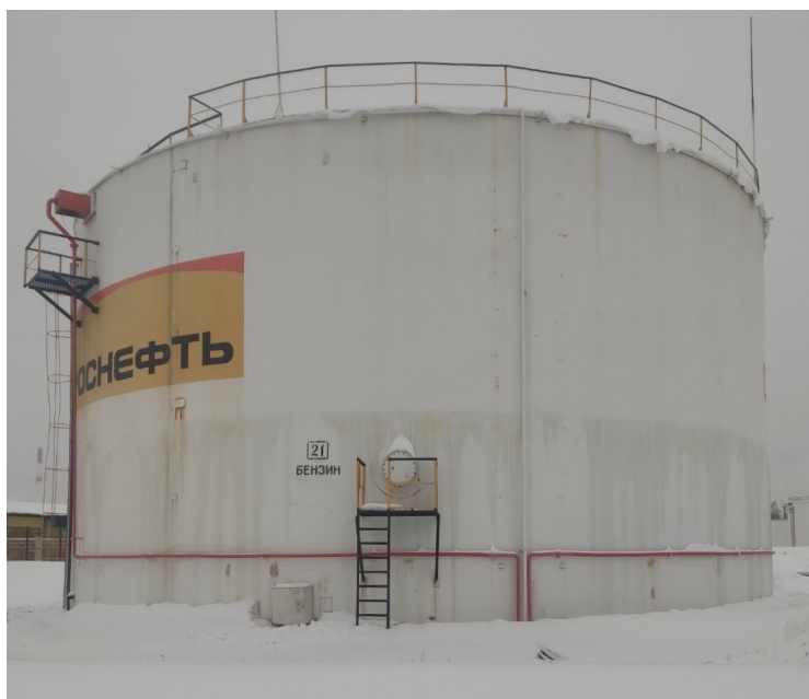
Рисунок 1 – Общий вид резервуаров РВСП-5000
