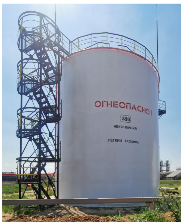
Рисунок 1 – Общий вид резервуара РВС-1000
