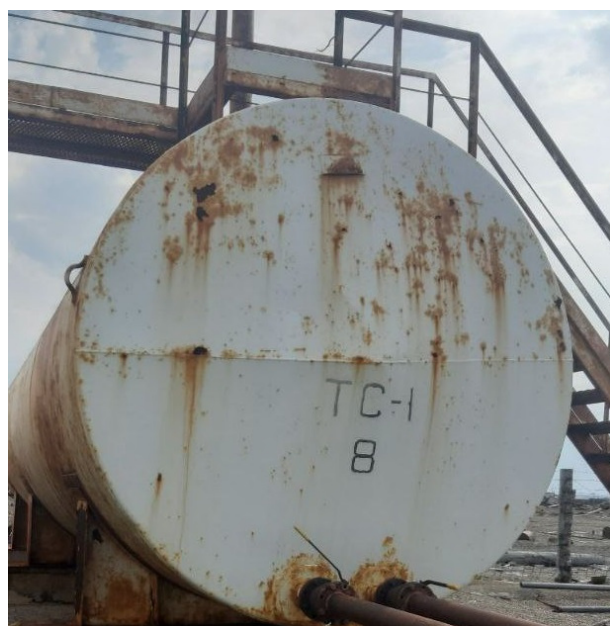
Рисунок 4 – Общий вид резервуаров РГС-60 №8
