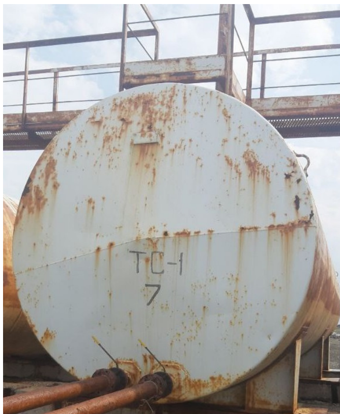
Рисунок 3 – Общий вид резервуаров РГС-60 №7
