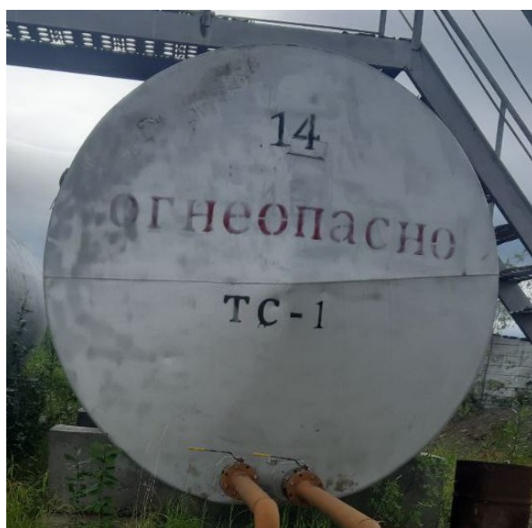
Рисунок 10 – Общий вид резервуаров РГС-60 №14
