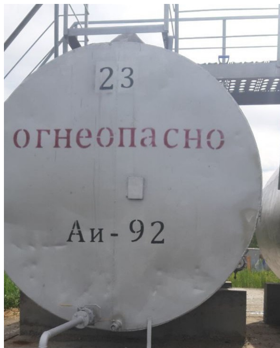
Рисунок 19 – Общий вид резервуаров РГС-25 №23
