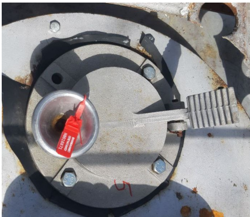
Рисунок 1 – Общий вид резервуаров РГС-60 №5
