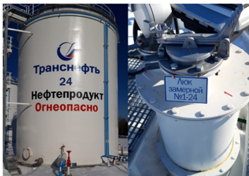
Рисунок 1 - Общий вид резервуара стального вертикального цилиндрического РВС-1000, заводской № 24
