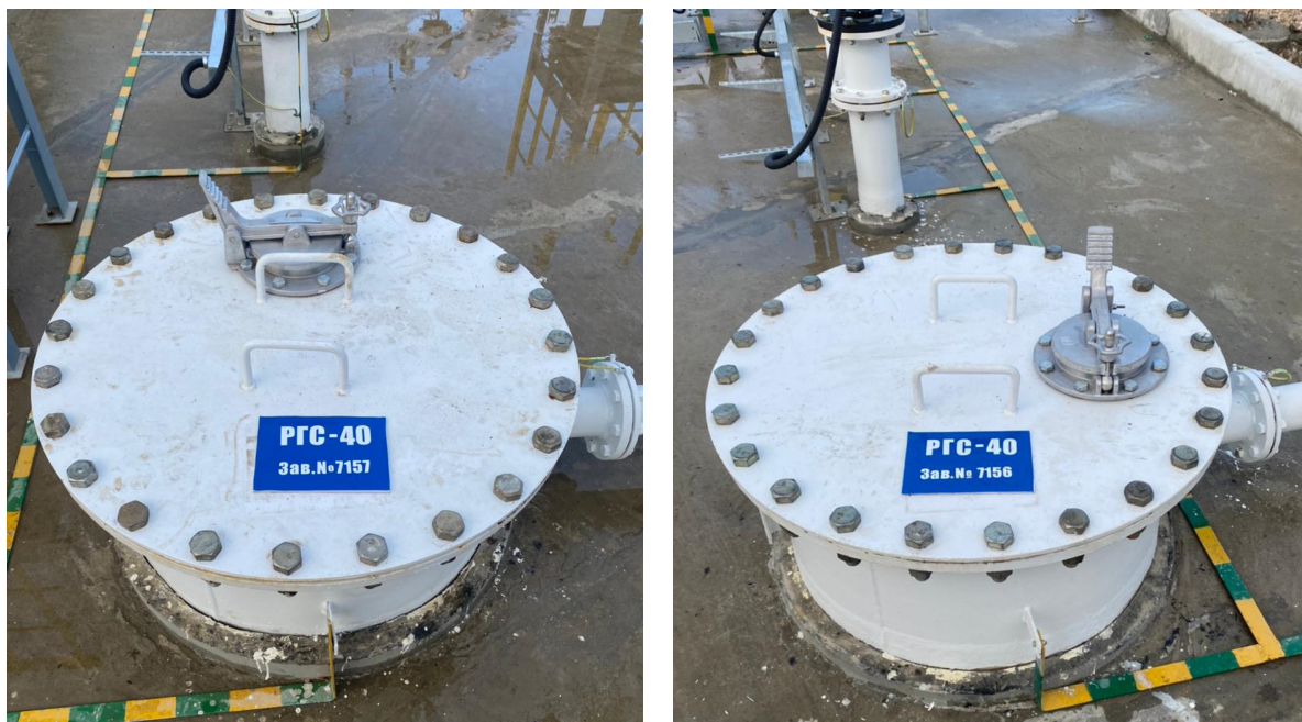
Рисунок 3 - Место нанесения заводских номеров резервуаров РГС-40
