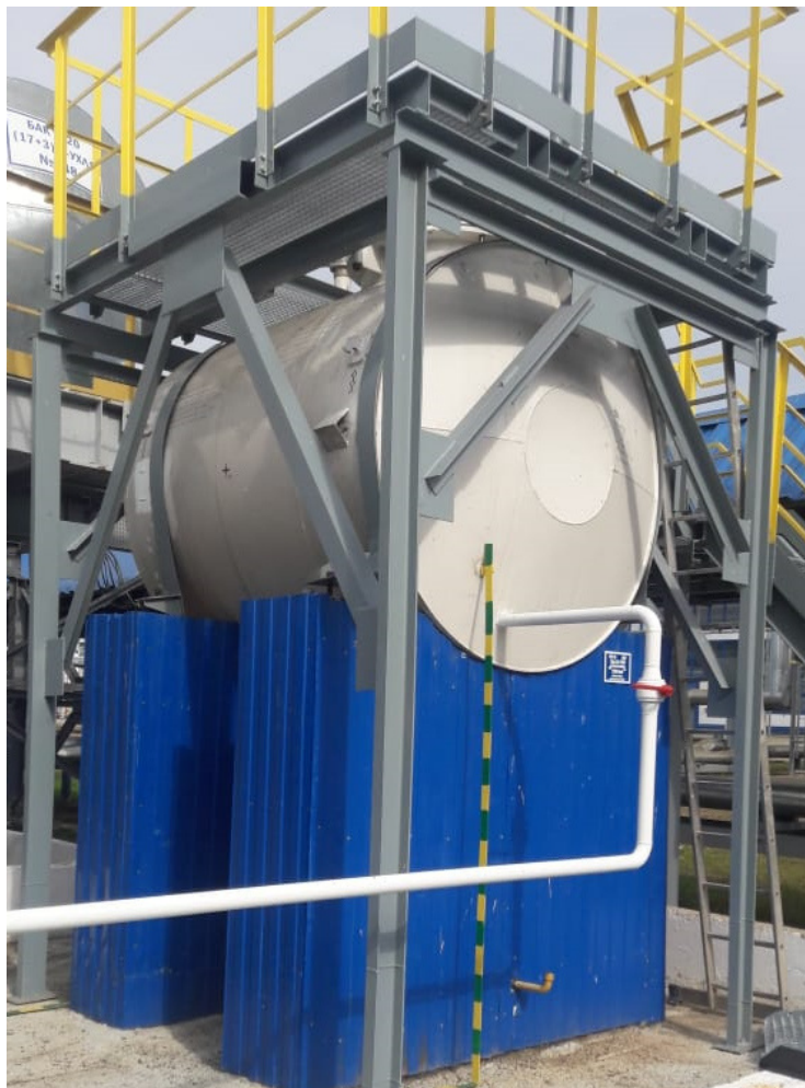
Рисунок 1 - Общий вид резервуара РГС-5
