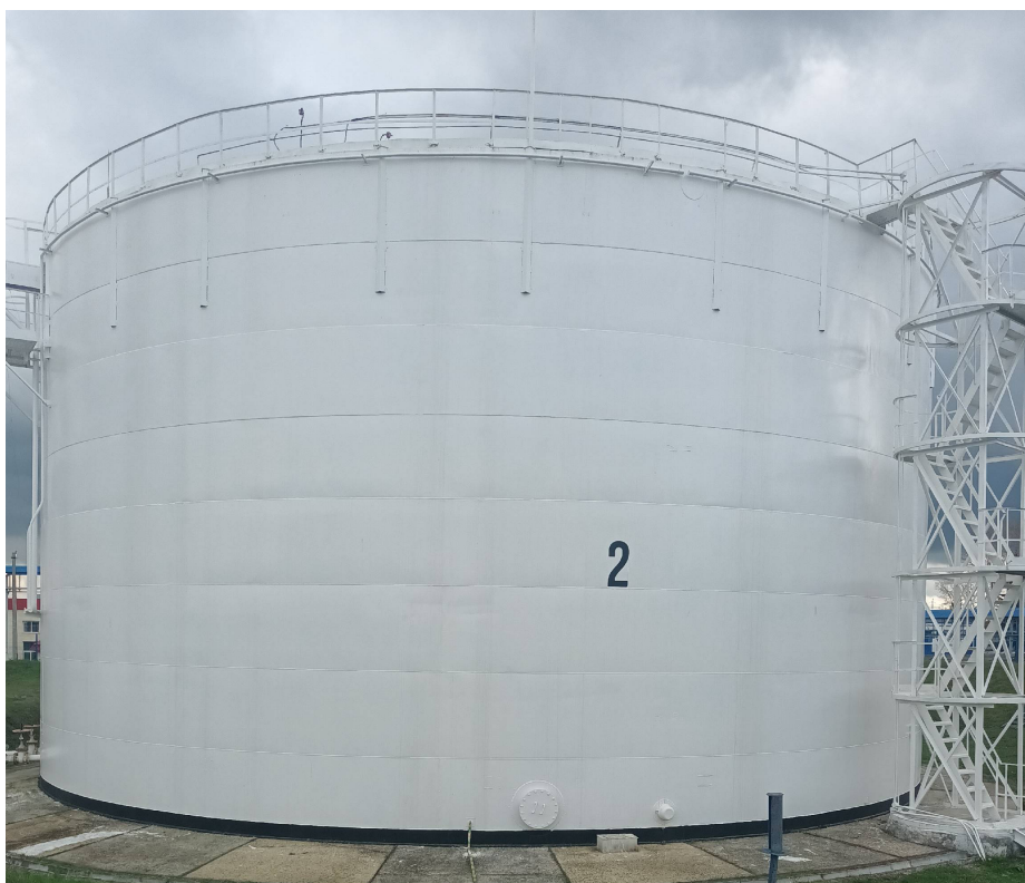
Рисунок 2 - Общий вид резервуара № 2
