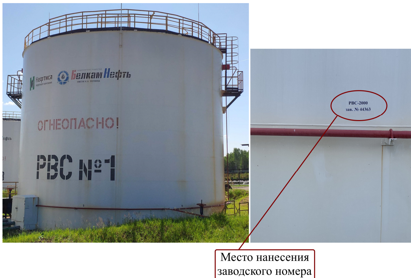
Рисунок 1 – Общий вид резервуара РВС-2000 с указанием места нанесения заводского номера Пломбирование резервуара РВС-2000 не предусмотрено.
