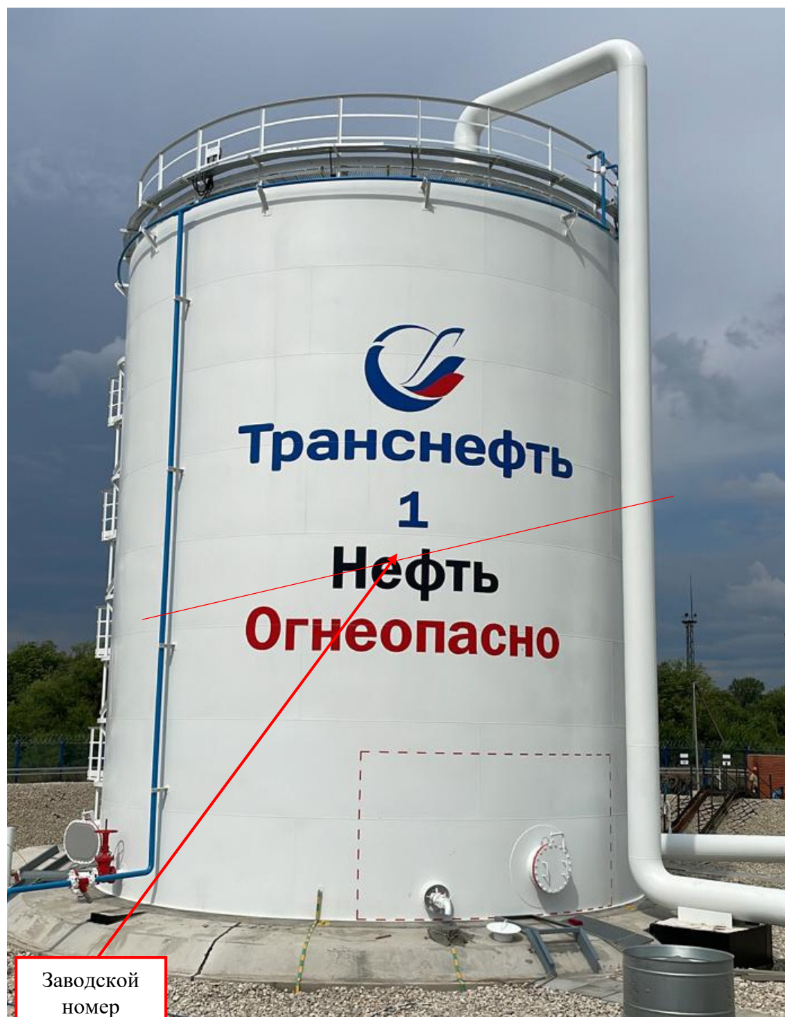
Рисунок 1 - Общий вид резервуара вертикального стального цилиндрического РВС-1000 заводской номер 1 с указанием места нанесения заводского номера
