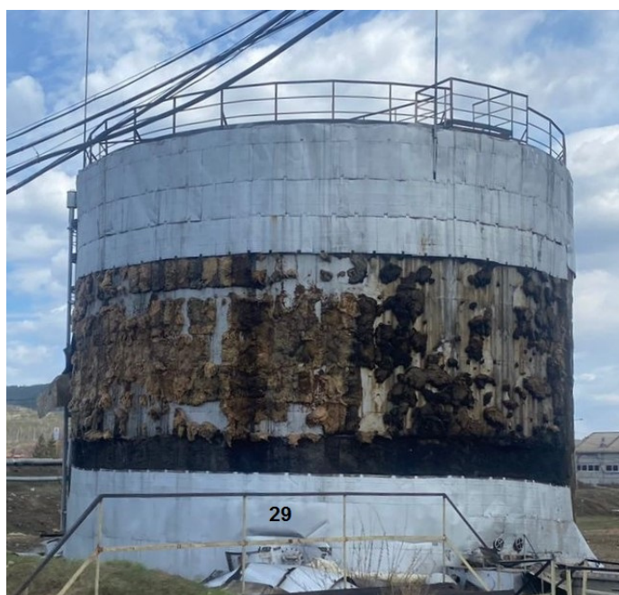
Рисунок 1 – Общий вид резервуара РВС-2000
