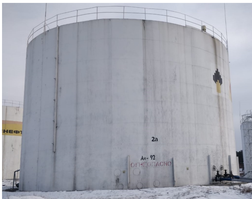
Рисунок 1 – Общий вид резервуаров РВС-3000
