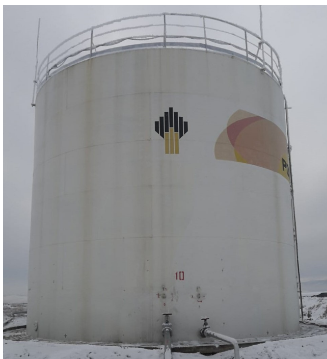
Рисунок 1 – Общий вид резервуаров РВС-700
