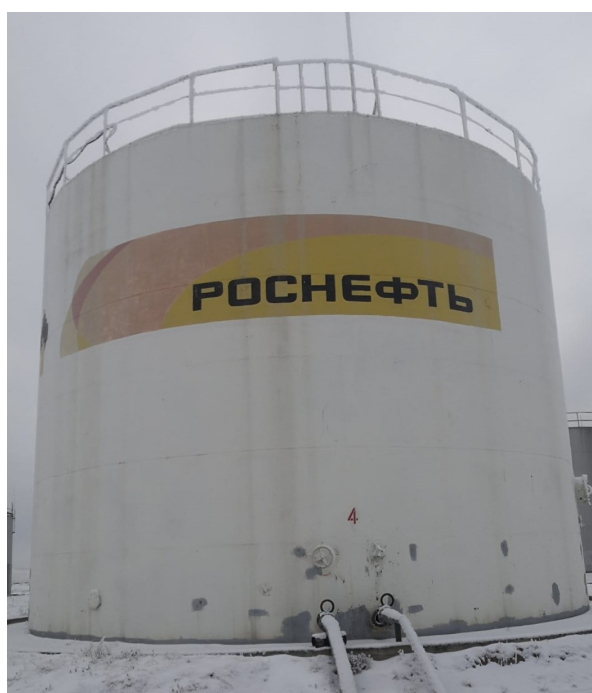
Рисунок 1 – Общий вид резервуаров РВС-1000
