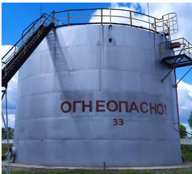
Рисунок 1 – Общий вид резервуара РВС-1000
