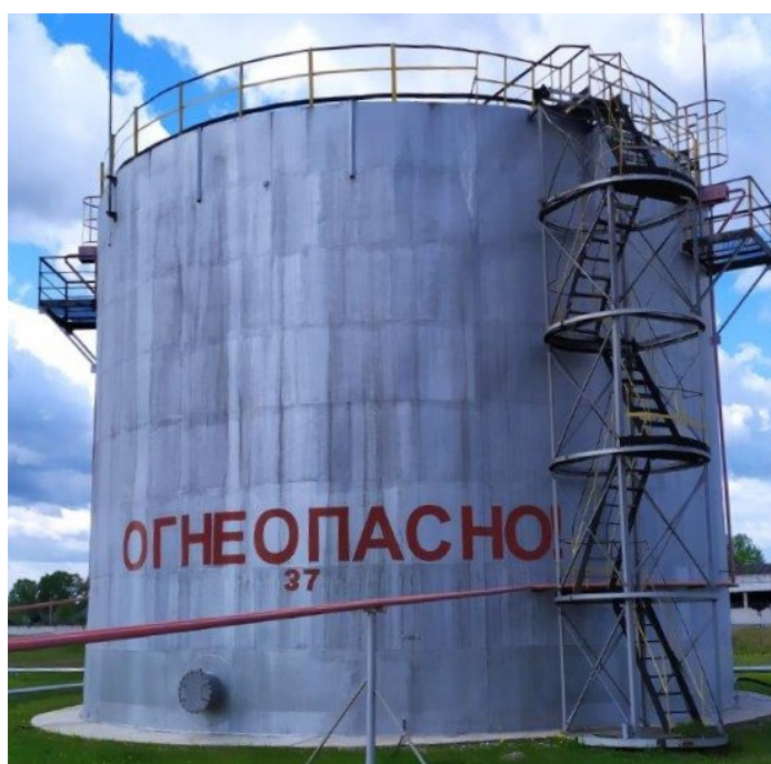
Рисунок 1 – Общий вид резервуара РВС-2000
